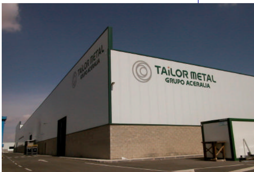
Foto 1. Instalaciones de Tailor Metal
