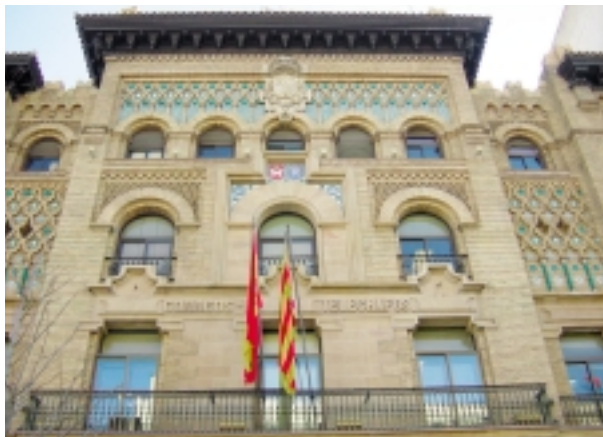
Edificio de Correos. Oficina principal en Zaragoza
