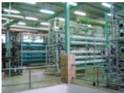
Vista planta de ósmosis inversa
