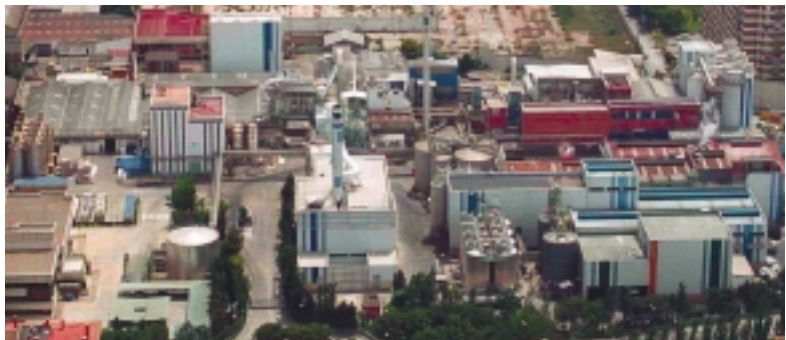
Vista general de la planta
