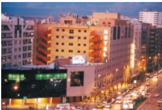
Edificio Hotel Boston
