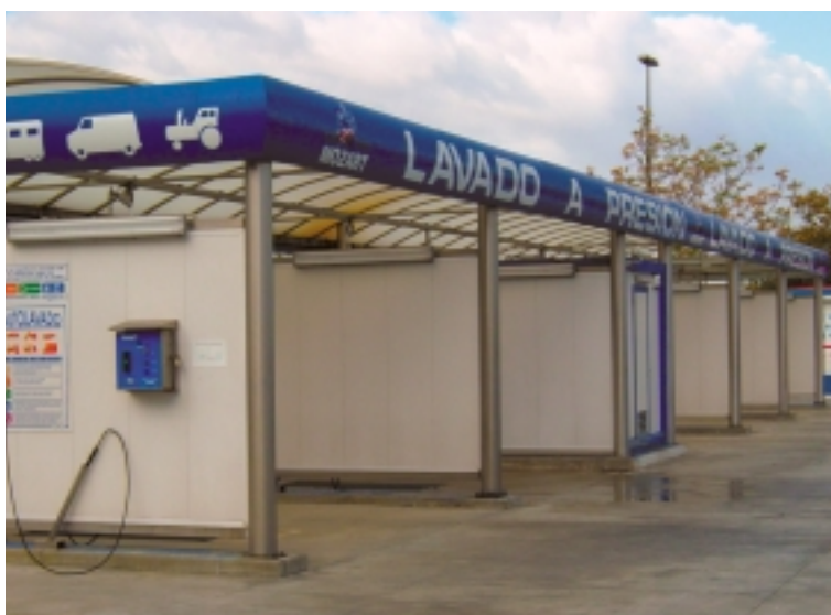
Instalación de autolavado
